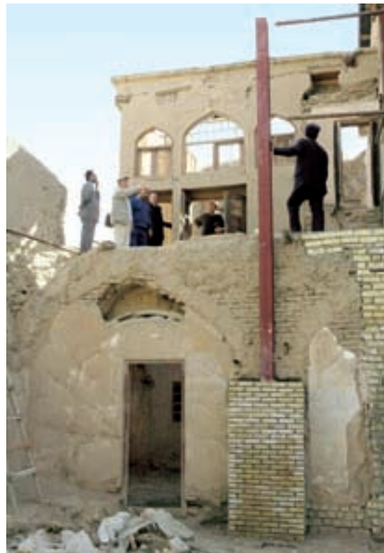
Casa safavide: a destra un primo intervento di consolidamento strutturale (novembre 2005).
