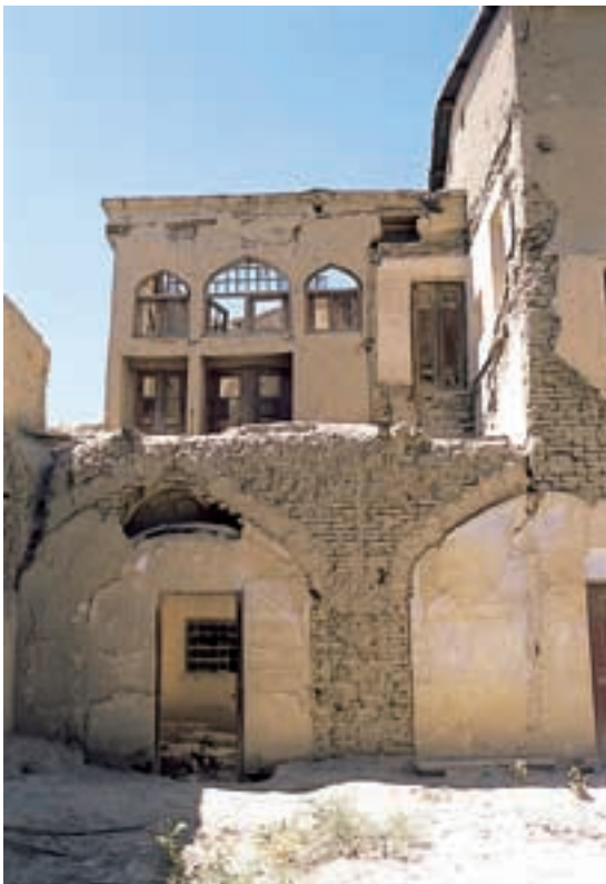
Casa safavide: a destra un primo intervento di consolidamento strutturale (novembre 2005).
